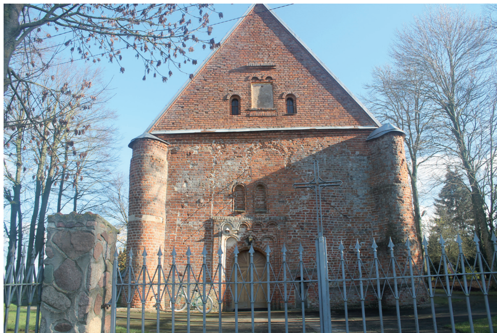
Fot. 3. Kościół parafialny w Pawłowie Kościelnym, stan obecny
