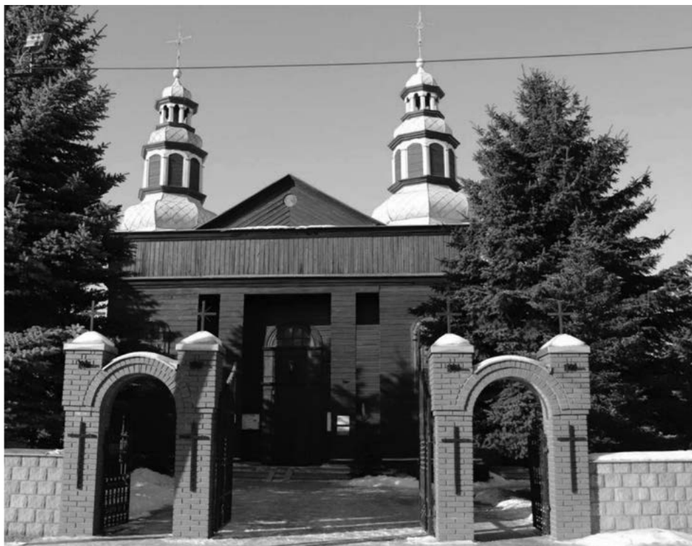
Ryc. 15. Mochowo, kościół pw. św. Marcina, fasada, widok od wschodu
