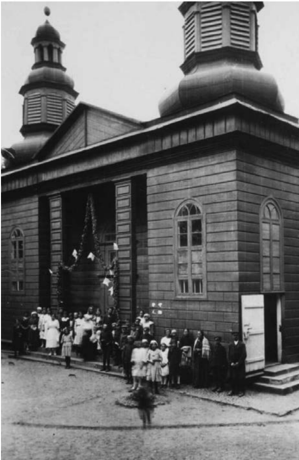
Ryc. 10. Mochowo, kościół pw. św. Marcina, fasada z 1876 r.
